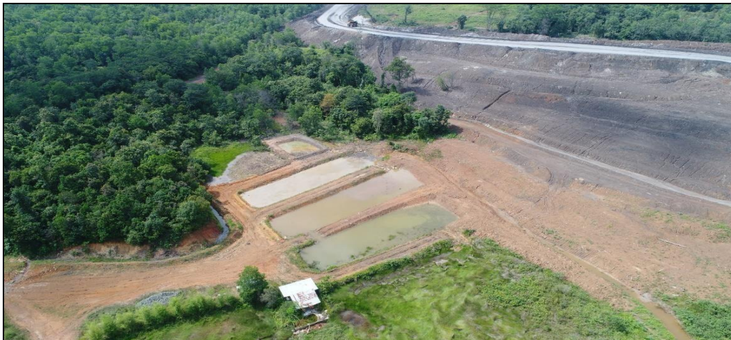
Gambar 5. Kolam pengendap lumpur pit 3 Barat Banko Barat Sumber: Sari et.al (2018)
