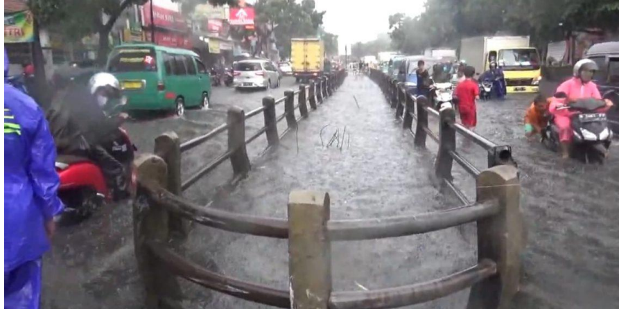
Gambar 1. Banjir di ruas jalan Leuwipanjang
