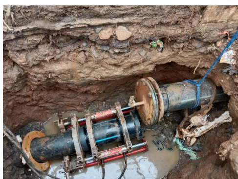
Gambar 8. Perbaikan Pipa HDPE
