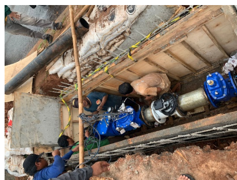
Gambar 15. Pemasangan PRV dalam Meter Induk
