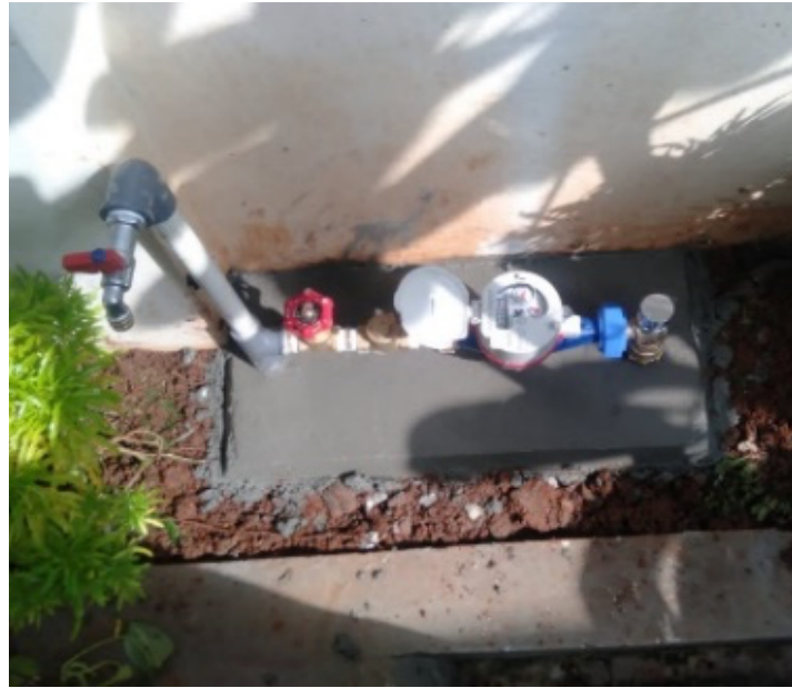
Gambar 16. Pemasangan Meter Air Sesuai Standar Perusahaan
