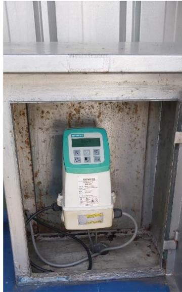
**Gambar 4** *Electronic Flow Meter* di Pipa *Discharge* Jalur Kaum Pandak
