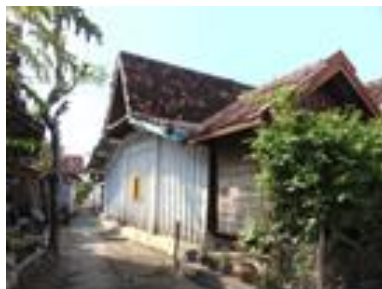
Gambar 4 Kondisi Rumah Tradisional Sumber: Survey Lapangan
