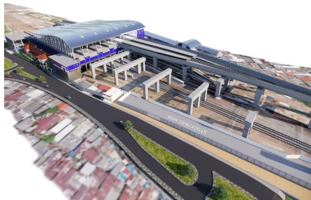
Gambar 18 Penyelesaian Pekerjaan Tahap II Sumber: Dokumentasi Pribadi, 2021
