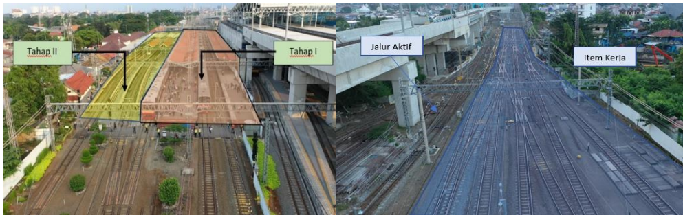
Gambar 4 Area Kerja Mainline I Sumber: Dokumentasi Pribadi, 2021
