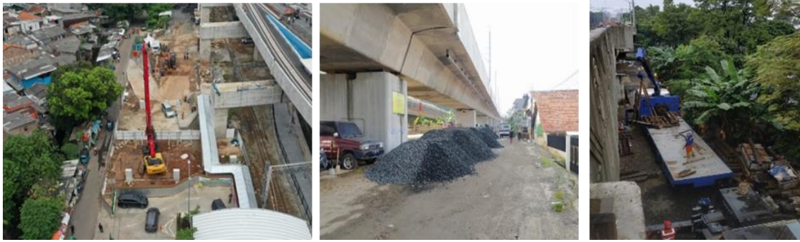
Gambar 8 Pemakaian Alat Bore Pile pada Gedung Skybridge Area Stockyard Ballast dan Mobilisasi Alat
