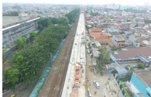
Gambar 5 Lahan Kerja Track Bogor Line Elevated Bulan Maret 2020 Sumber: Dokumentasi Pribadi, 2021
