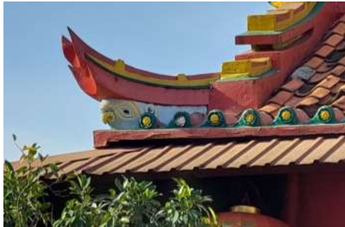
Gambar 2 Bubungan Lancip (Sumber: Dokumentasi Pribadi, 2022)
