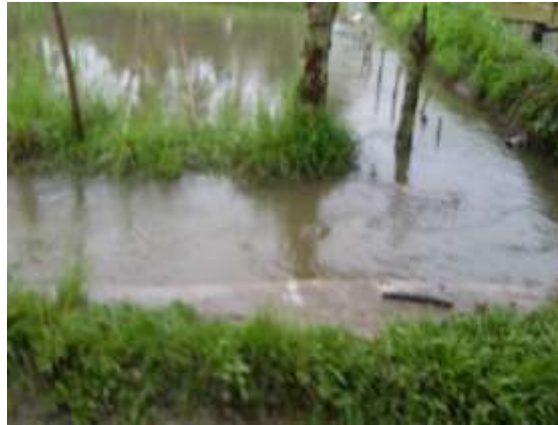
Gambar 3 Drainase Eksisting Desa Kisam Lestari Kanan
