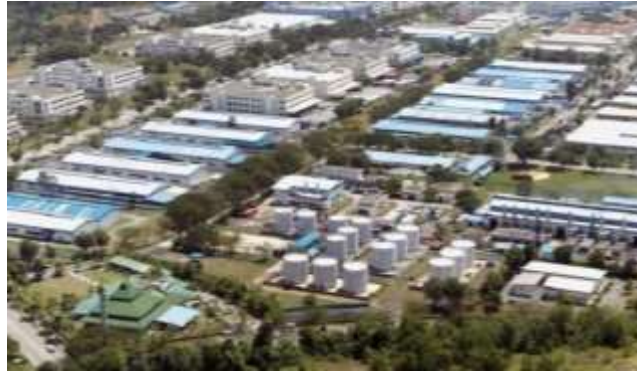
Gambar 1 Kawasan Batamindo Industrial Park
