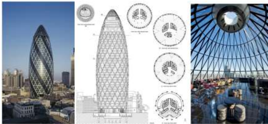
Gambar 11. Swiss Re Headquarters Dan Panorama Dari Puncak Bangunan
